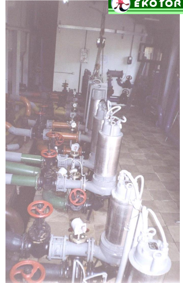
Локальные очистные сооружения оздоровительного комплекса «Бор». Производительность 1000 м 3 /сут. 2003, Московская обл., Россия
