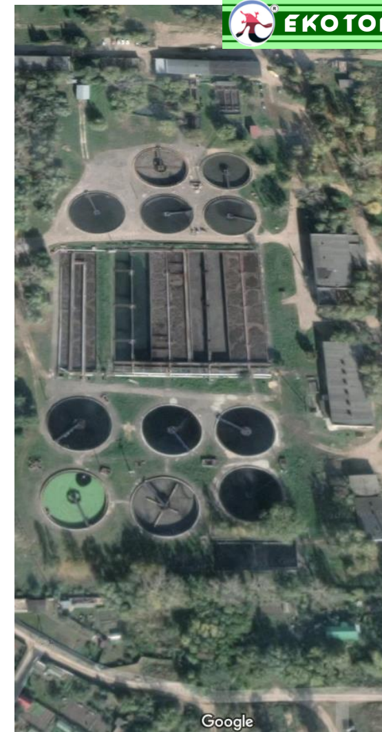
Переработка илового осадка на КОС гор. Коломна. Производительность по сточным водам 90 тыс. м 3 /сут. 2014, Московская обл., Россия
