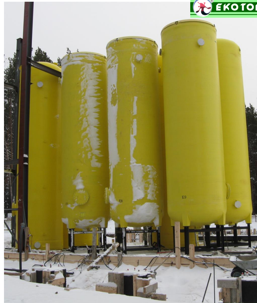
Локальные очистные дома-интерната «Лесная дача». Производительность 500 м 3 /сут. 2012, Томская обл., Россия
