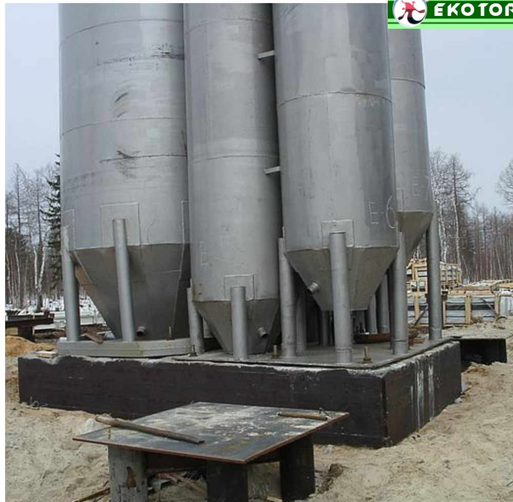
Локальные очистные сооружения Вынгапурского газового промысла, филиал «Газпром». Производительность 150 м 3 /сут. 2006, Ямало-Ненецкий АО, Россия
